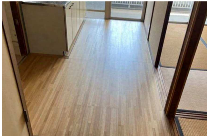
【バリアフリー化事業】 (洋室と和室の床段差解消)
