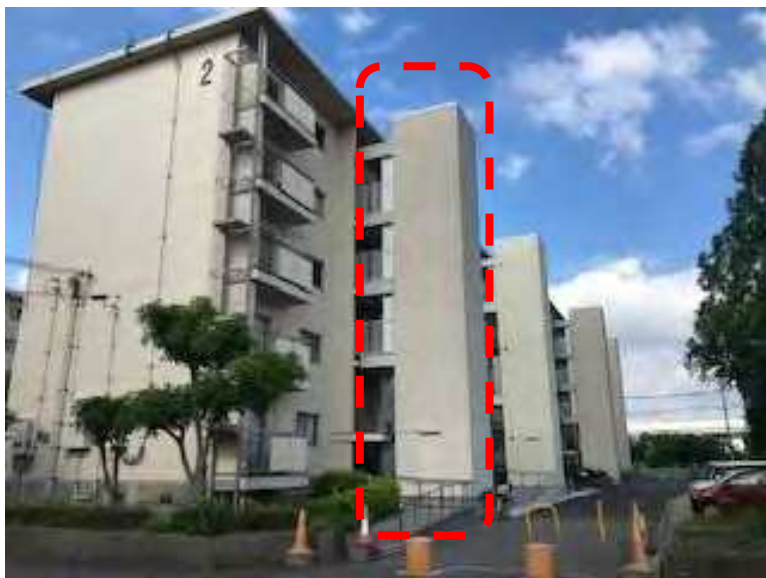
【既存中層住宅エレベーター設置事業】
