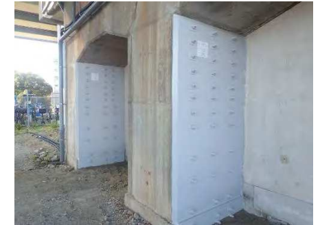
写真 1：鉄道耐震補強状況 (阪神 淀川駅)
