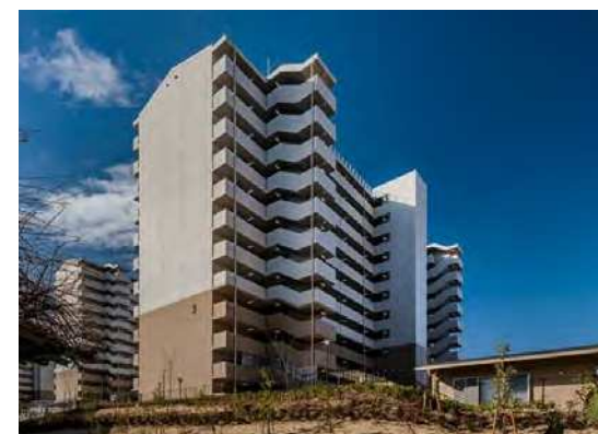
【建設事業（建替）】 豊中新千里南住宅
