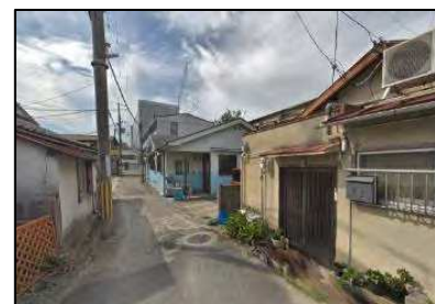
老朽建築物除却前
