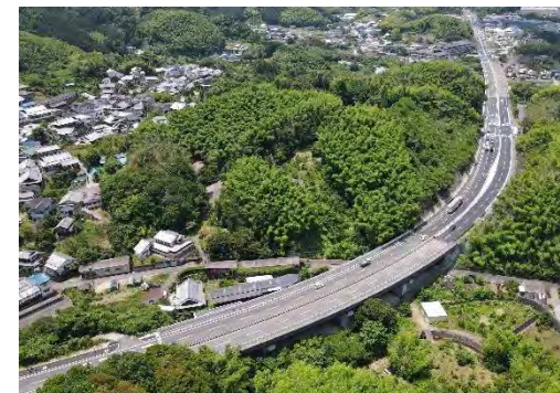
写真 3：国道 170 号（若樫工区）（和泉市）
