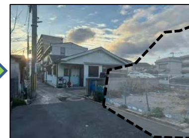
老朽建築物除却後
