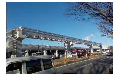
写真 7：大阪モノレール延伸事業
