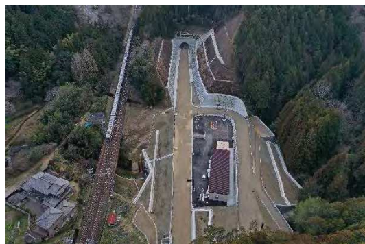
写真 1：国道 371 号（石仏バイパス）（河内長野市）
