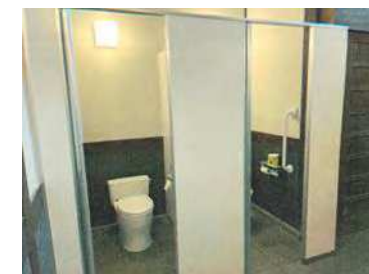
ほりご園地 衛生器具再整備 (泉南市堀河)
