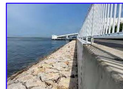
緩傾斜護岸 (補修後)
