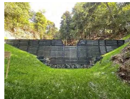
治山ダム (交野市寺地区)
