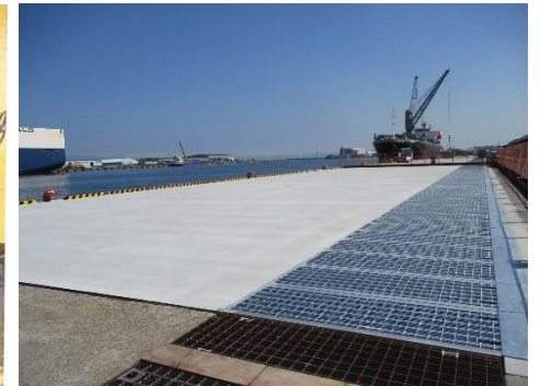
写真2：堺泉北港汐見第3号岸壁更新状況(泉大津市)
