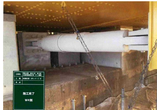
写真1：泉大津大橋耐震化状況 (泉大津市)
