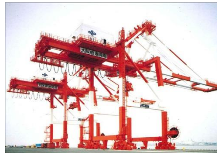
写真3：ガントリークレーン
