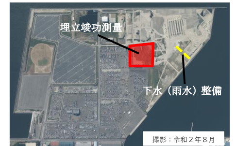
写真2：堺泉北港汐見沖地区整備事業
