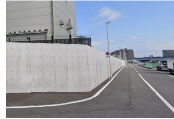
写真2：堺泉北港海岸堺新港地区【堺市】 (高潮対策)
