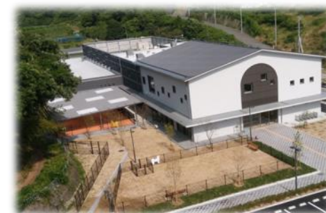
大阪府動物愛護管理センター
