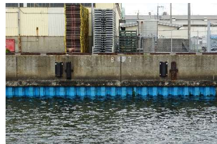
写真1：松ノ浜第1号岸壁補修工事 補修状況(泉大津市)
