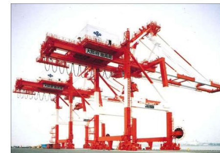
写真3：ガントリークレーン
