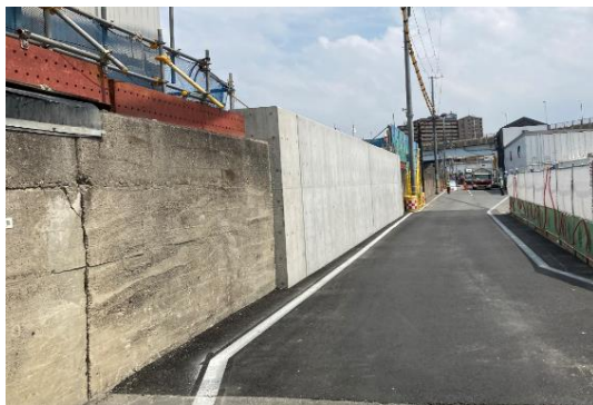
写真：堺泉北港海岸 堺新港地区【堺市】 (高潮対策)
