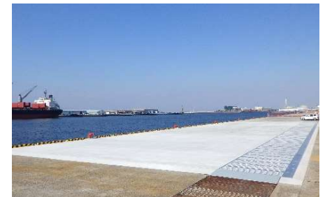
写真2：堺泉北港汐見第3号岸壁 更新状況(泉大津市)
