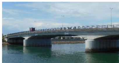
写真 1 阪南港貝塚大橋 耐震対策状況 (貝塚市)
