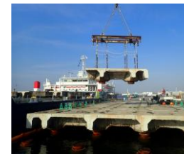
写真 3 堺泉北港汐見第 3 号岸壁 上部工撤去状況 (泉大津市)
