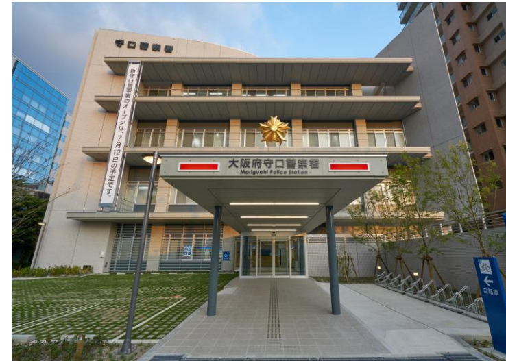
【大阪府守口警察署新築工事】
