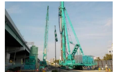
写真7：大阪モノレール延伸事業
