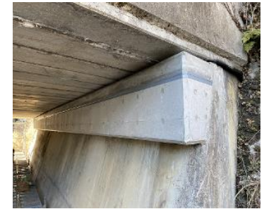
写真5：国道 423 号 女美尾橋(豊能町)
