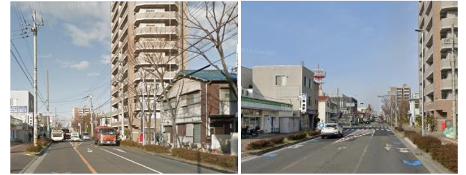
写真4：大阪港八尾線(左：工事前 右：工事後)
