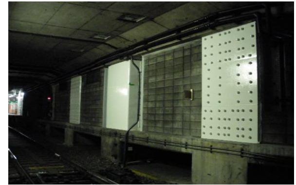
写真 1：鉄道耐震補強状況 (OsakaMetro 中央線 国道 308 号並走部)
