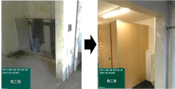
写真2：トイレ改修（箕面公園）
