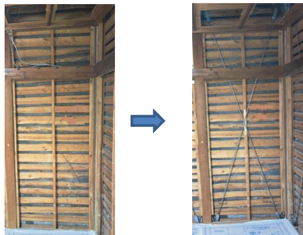
【耐震改修工事】
