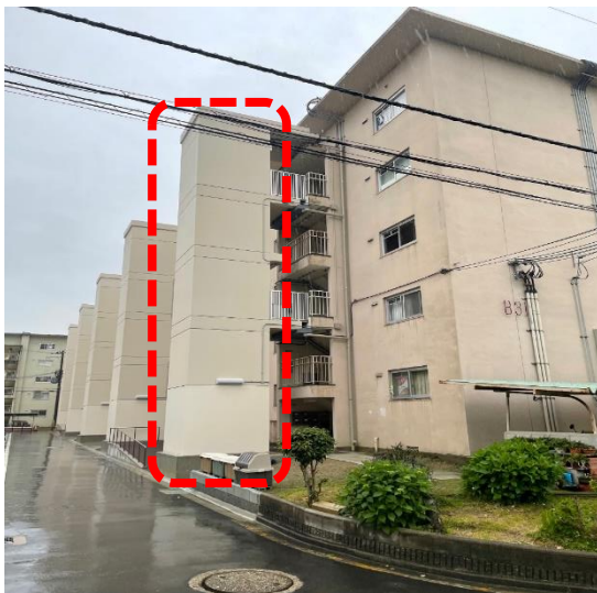
【エレベーター設置事業】
