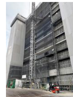
令和7年住宅棟建築中
