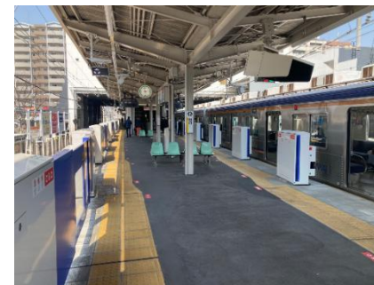
写真3：可動式ホーム柵整備状況 （南海 中百舌鳥駅）
