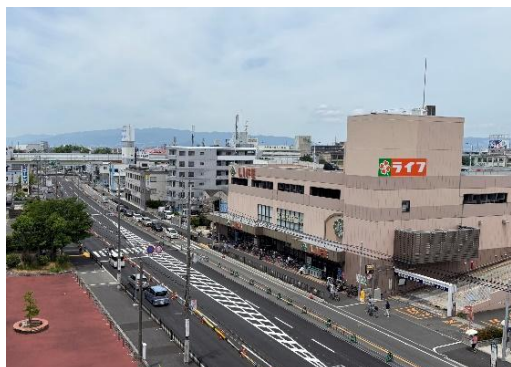
写真２：都市計画道路三国塚口線（豊中市） (令和 8 年 6 月供用)
