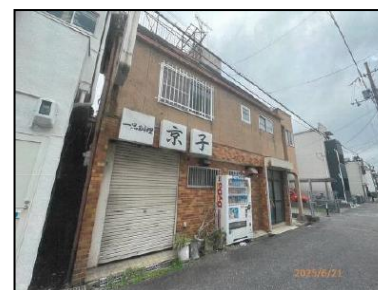
老朽建築物除却前
