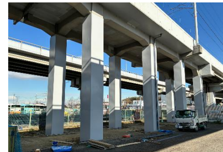
写真1：鉄道耐震補強状況（南海泉北線）
