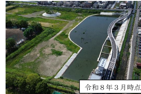
写真3：恩智川（法善寺）多目的遊水地
