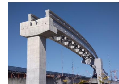
写真 7：大阪モノレール延伸事業
