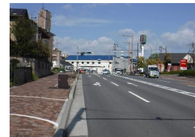
写真 4：一般国道 170 号（抜柱後）（羽曳野市）
