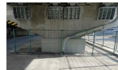
写真 5：府道八尾茨木線 仁和寺高架橋（落橋防止装置設置状況）（寝屋川市）
