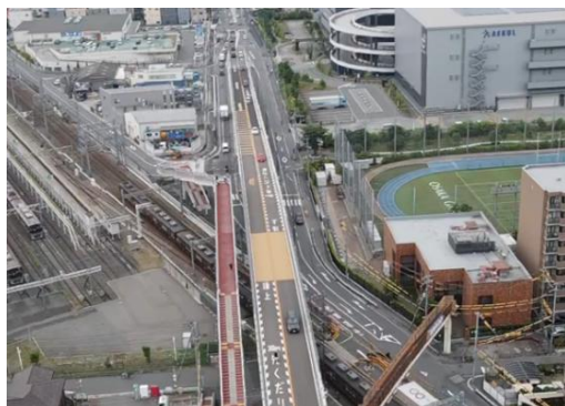
写真１：都市計画道路十三高槻線（正雀工区）（吹田市） (令和 7 年 6 月供用)
