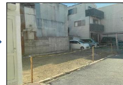
老朽建築物除却後
