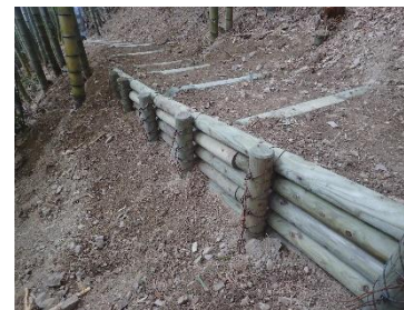
近畿自然歩道整備工事 (岬町多奈川)
