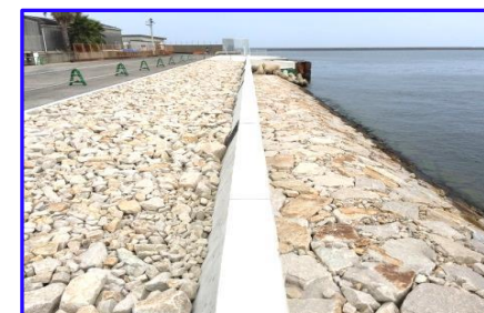
緩傾斜護岸 (補修後)
