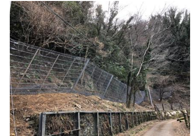
なるかわ園地 落石防止対策工事 (東大阪市上六万寺)
