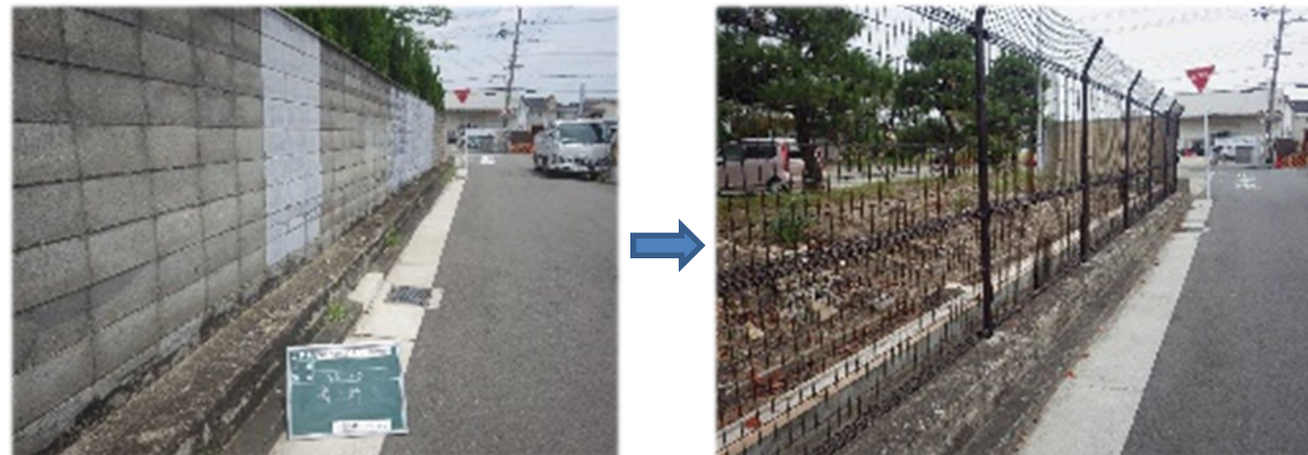
【ブロック塀除却工事】
