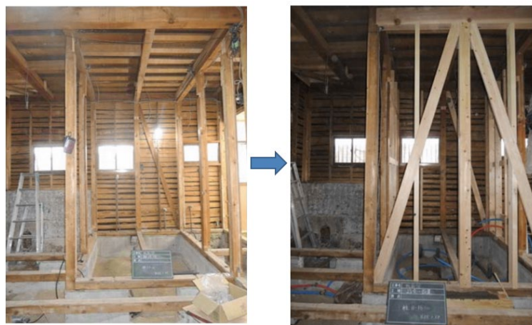
【耐震改修工事】
