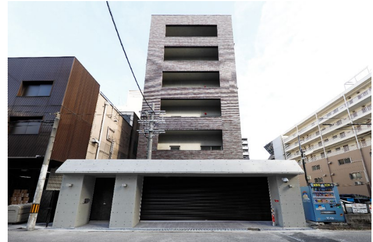
【大阪府南警察署島之内別館（仮称）新築工事】
