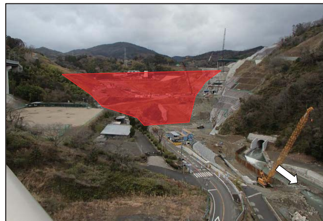
写真2：安威川ダム建設事業（平成30年3月時点）
