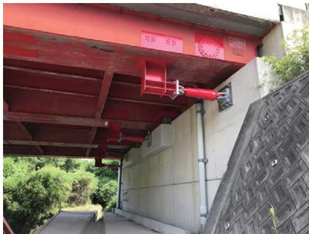
写真4：国道170号 積川大橋(耐震補強) (岸和田市)
