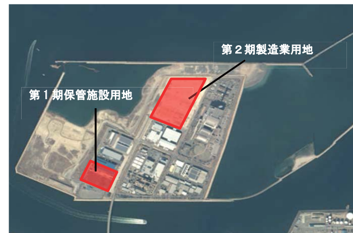
写真1：阪南港阪南2区整備事業(岸和田市)
