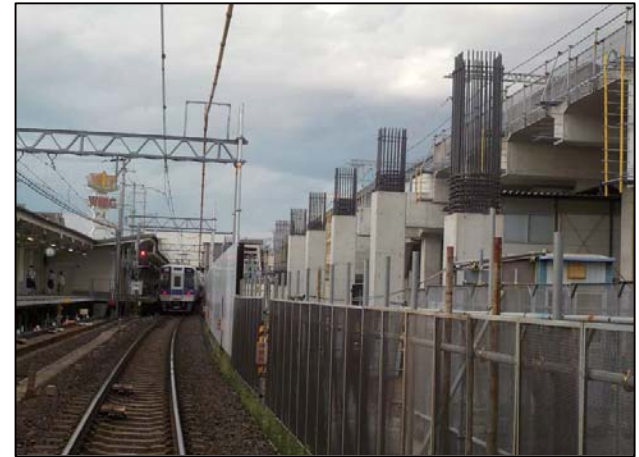
写真3：南海本線 連続立体交差事業(高石市)
