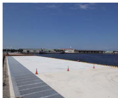
写真1：堺泉北港汐見第3号岸壁 (泉大津市)
