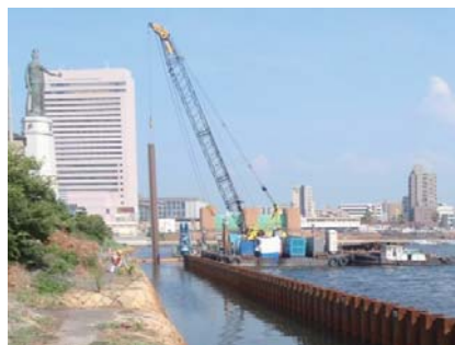
写真1：堺泉北港海岸堺市堺港旧港地区 南海トラフ巨大地震対策(堺市)
