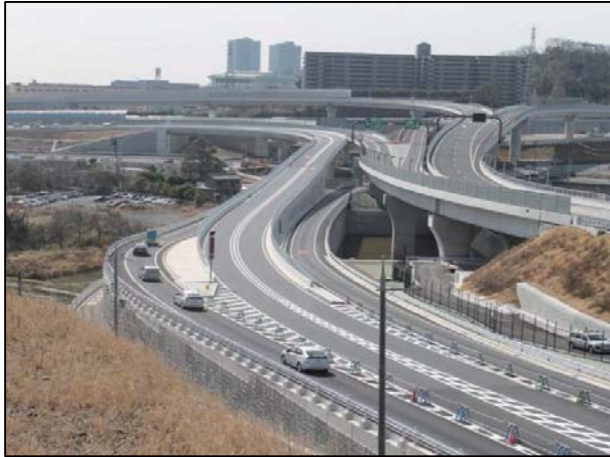
写真1：新名神高速道路高槻IC アクセス道路(高槻市)
