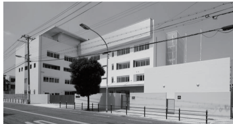
【大阪府立大阪南視覚支援学校改築工事】
