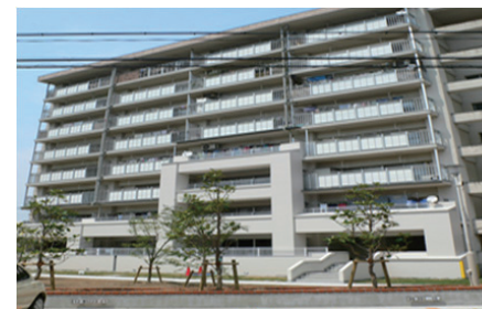
【耐震改修事業 (アウトフレーム工法)】
