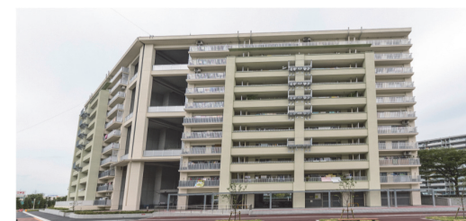
【耐震改修事業 (アウトフレーム工法)】
