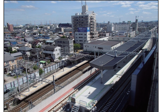
写真 3：南海本線下り線高架化(高石市)
