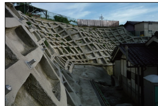
写真 3：畑(4)地区急傾斜地崩壊対策（柏原市）
