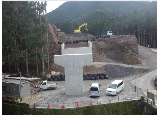
写真 2：府県間道路 国道 480 号(和泉市)
