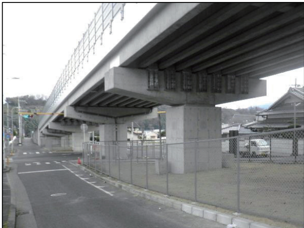
写真 4：国道 371 号 かつらぎ跨道橋(耐震補強) (河内長野市)
