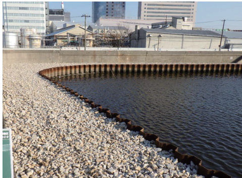
写真 1：堺泉北港海岸堺旧港地区 高潮対策 (南海トラフ巨大地震対策) 基礎部
