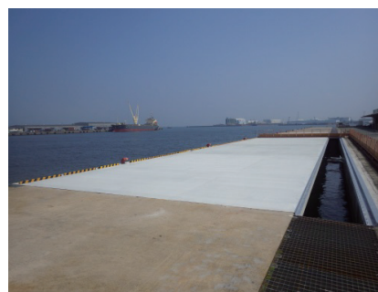
写真1：堺泉北港汐見地区3号岸壁(泉大津市)
