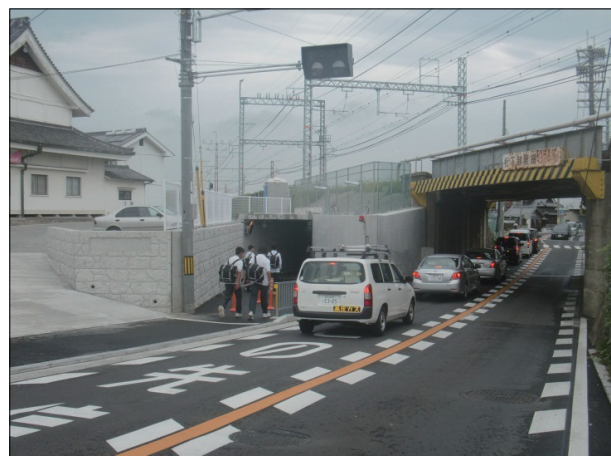
写真 5：河内長野美原線（通学路対策）
