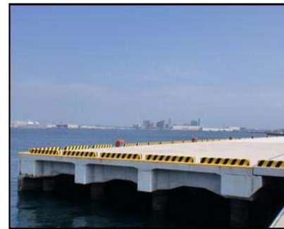
汐見沖地区 岸壁（H24 完成）
