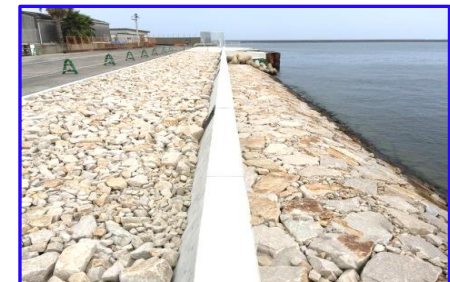
緩傾斜護岸 (補修後)
