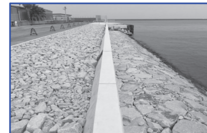
緩傾斜護岸 (補修後)
