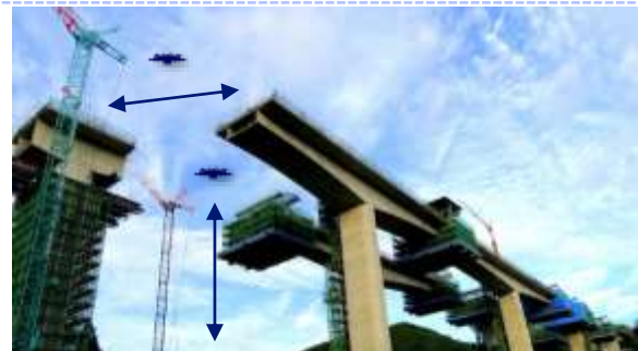
建設現場での資機材の輸送
