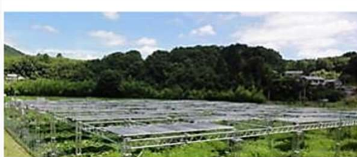
発電施設の外観
