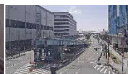
(仮称)舞洲東高架橋主桁架設中(令和6年3月)
