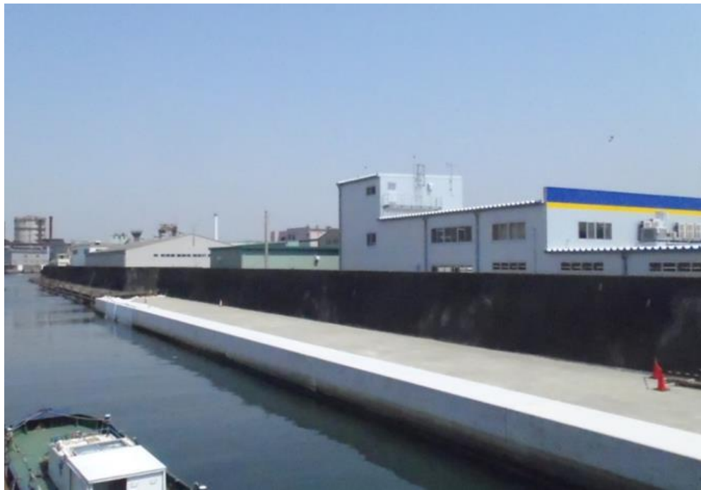
大阪市内（木津川下流部）における防潮堤
