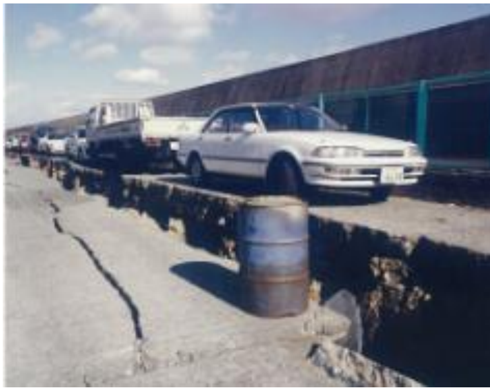
神崎川 神崎橋上流
