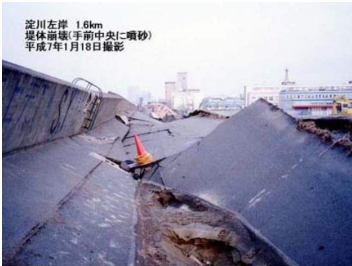
淀川左岸 西島地区
