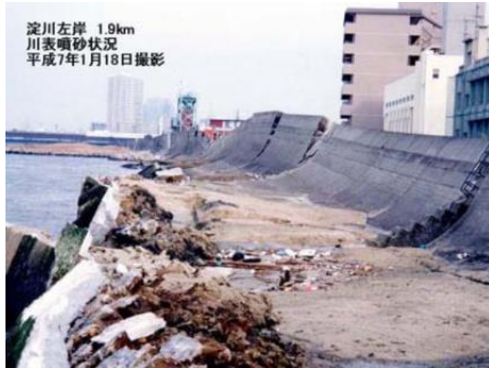
淀川左岸 西島地区
