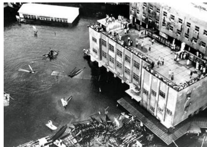
大阪市西淀川区の浸水
