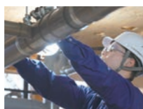
給排水設備施工実習
