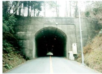
野間隧道（1936年建設 開削工法）
