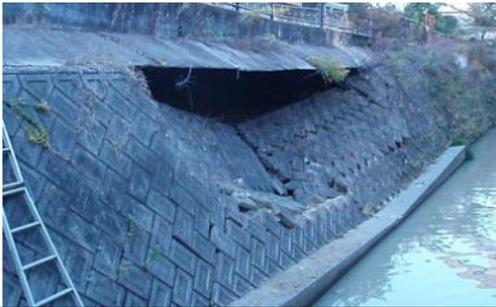
護岸背面土砂流出による護岸倒壊
