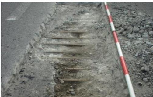
コンクリート床板の輪荷重による疲労損傷
