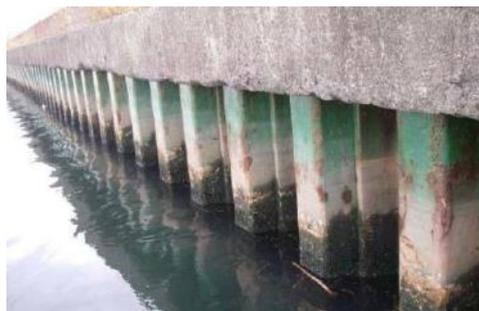
経年劣化による鋼矢板岸壁の腐食
