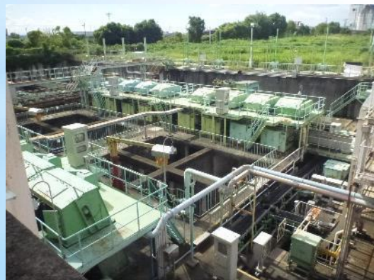
雨水沈砂池施設
