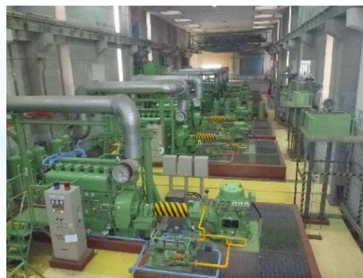
雨水ポンプ施設
