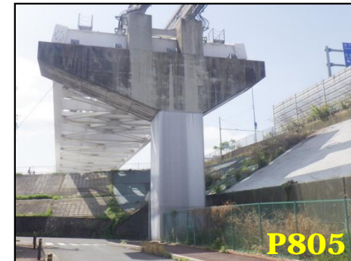
鋼板により耐震補強された支柱
