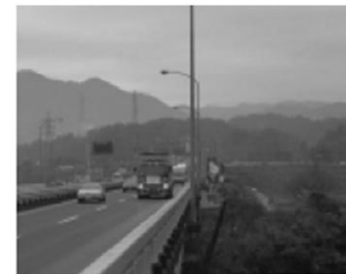
③重量既知車両走行試験
