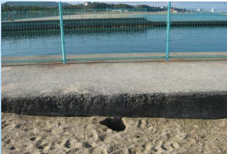
砂浜の陥没
