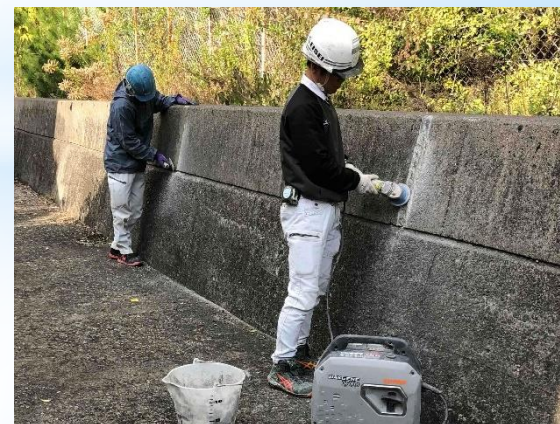
ひび割れ補修(部分)
