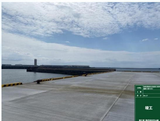
路盤+コンクリート舗装の更新(全面)
