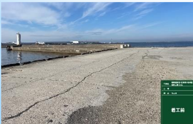
路盤+コンクリート舗装の更新(全面)
