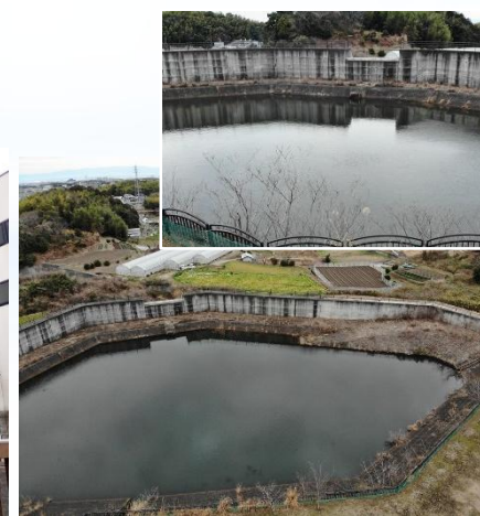
住吉川防災調節池
