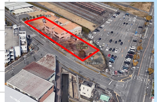
地上の状況 (大正川調節池)
