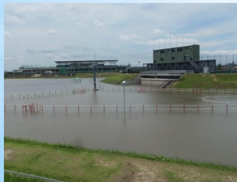
花園多目的遊水地 (排水門や越流堰のコンクリート部等)
