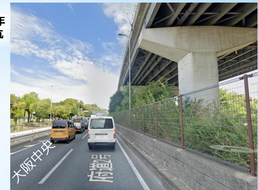
地上の状況（南部地下河川） 5
