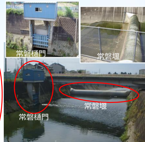
西除川常盤堰・常盤樋門 (堰柱、門柱等のコンクリート部等)
