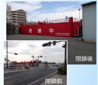
神崎川左門橋左岸鉄扉 (コンクリート部)
