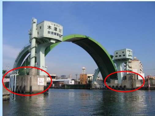
木津川水門 (堰柱、門柱等のコンクリート部等)
