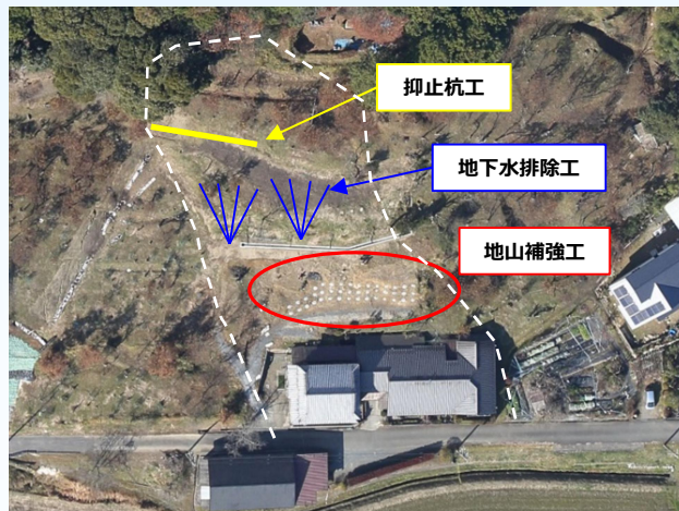
地すべり防止施設 (杭工・地山補強工・地下水排除工)
