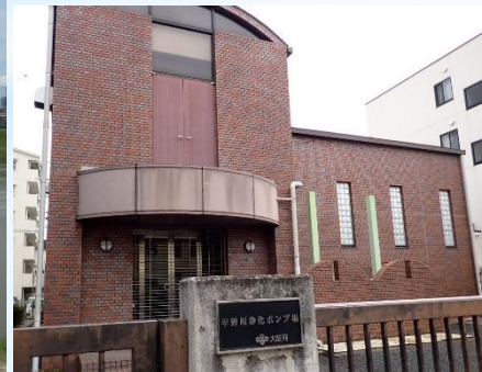
平野川浄化ポンプ場 (処理水放流渠等のコンクリート部等)
