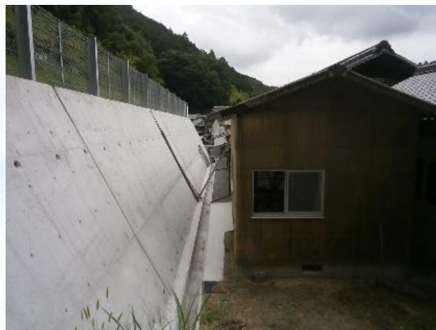
急傾斜地崩壊防止施設 (擁壁工)
