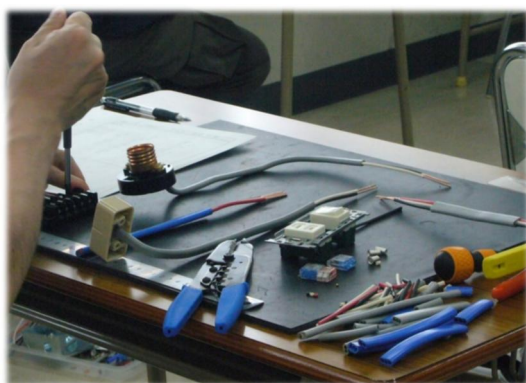
電気工事（技能）
