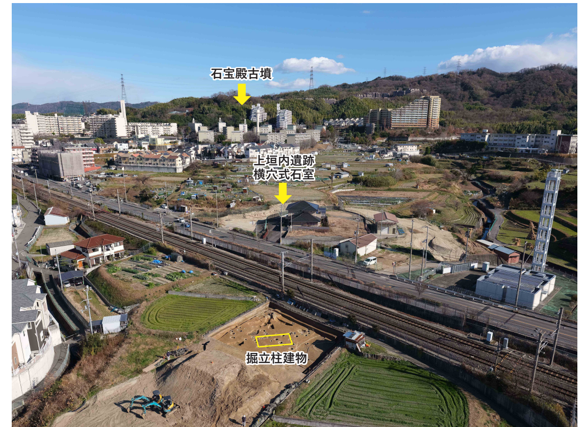
【写真1】 上垣内遺跡遠景(南西から)
