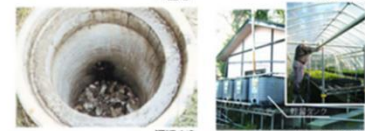
雨水貯留浸透施設の例
