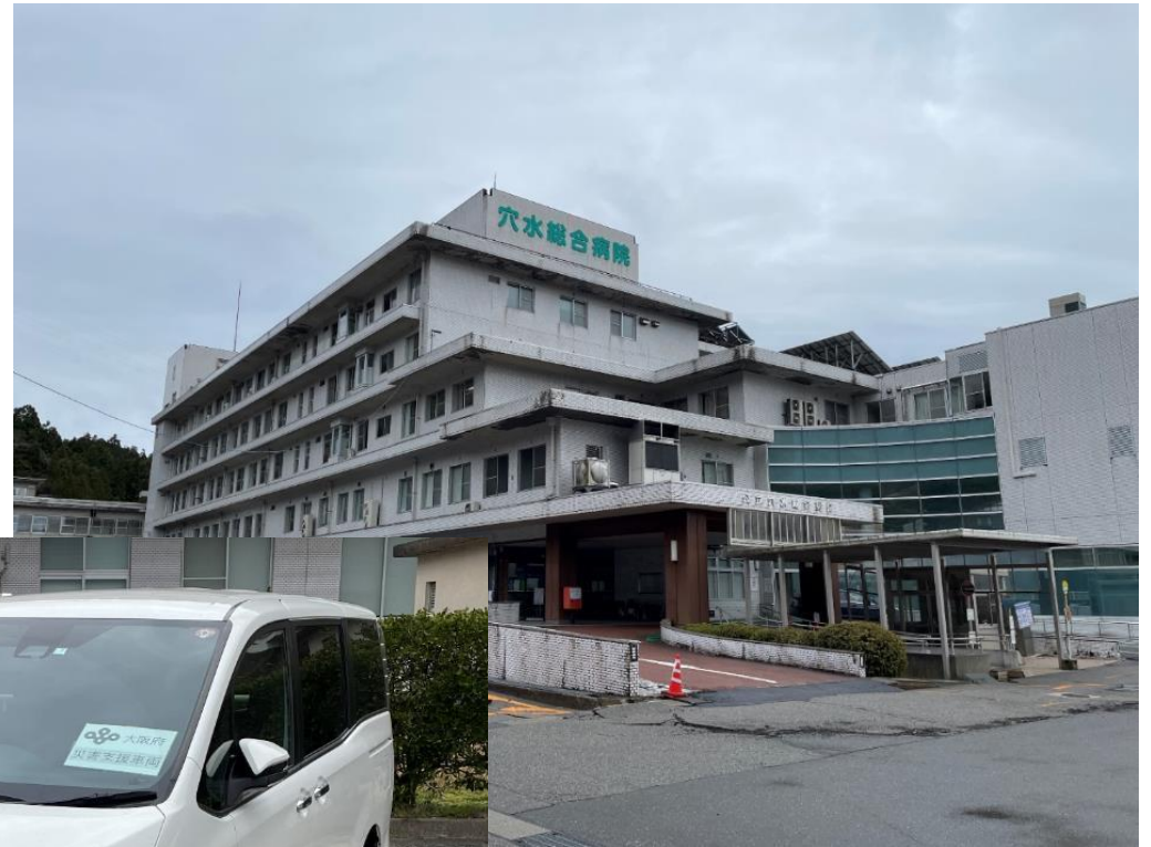
公立穴水総合病院
