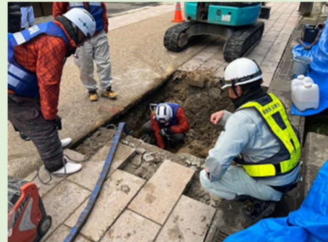
上水道復旧支援(能登町内)
