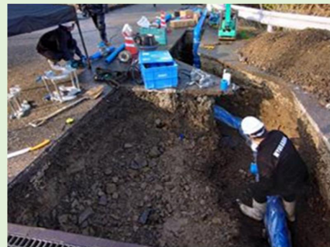
水道管復旧確認(能登町内)
