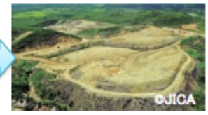
覆土によるごみの飛散・流出を防止
