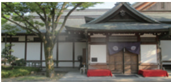
大阪迎賓館外壁塗装
