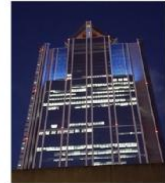
大阪府咲洲庁舎
