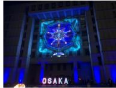
大阪府役所本庁舎
