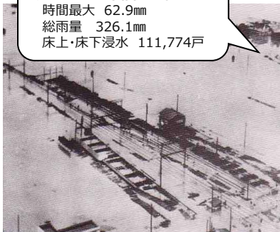
近鉄奈良線 八戸の里駅付近の浸水状況
