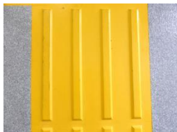
■ 誘導ブロック
