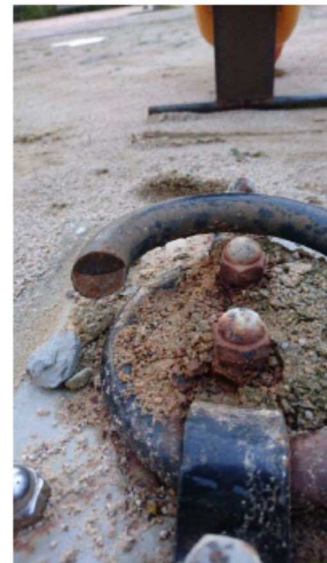
根本破断状況（拡大）
