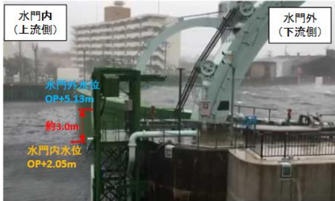
水門閉鎖後における木津川水門
