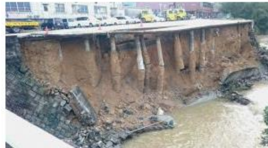
一級河川西除川 大阪狭山市茱萸木7丁目
