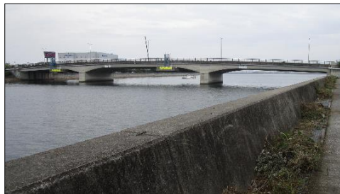
【貝塚大橋／耐震対策】（貝塚市）
