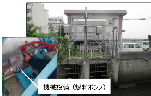
【車屋川排水機場／長寿命化対策】（阪南市）
