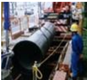
（管路更新工事※耐震化）
