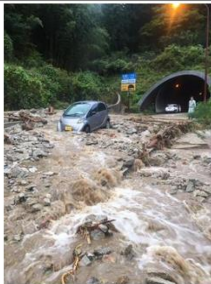
国道309号 水越峠 千早赤阪村 水分
