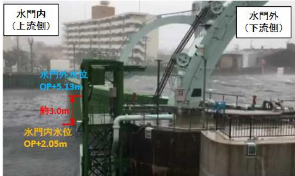
水門閉鎖後における木津川水門
