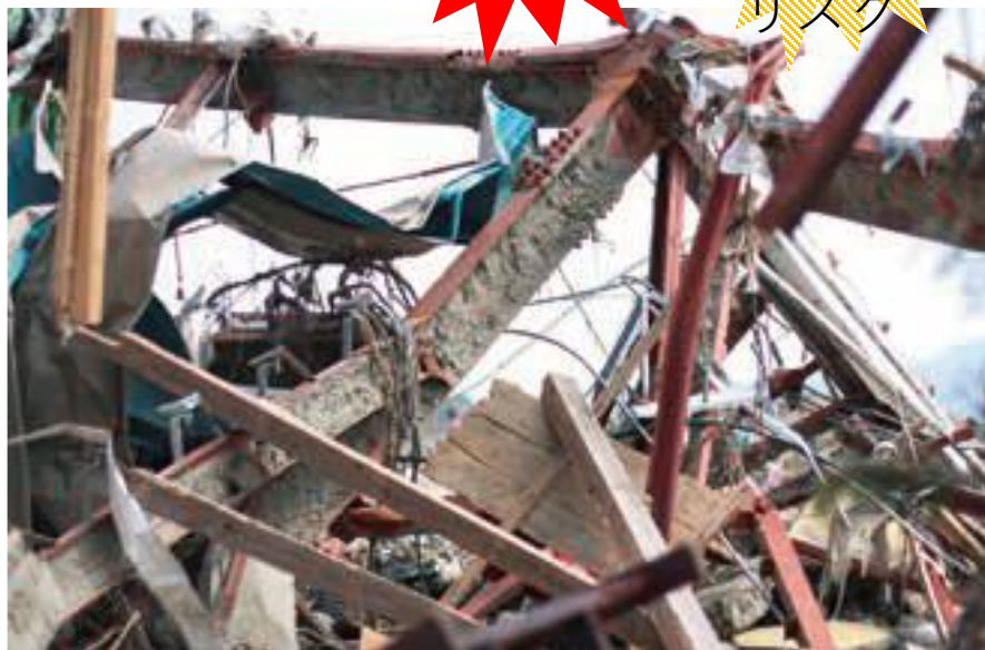
被災地で倒壊した建築物に混在する吹付け材
