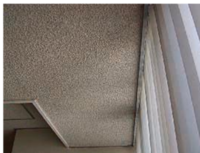
天井バーミキュライト仕上げ
