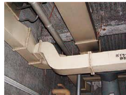
機械室の吹付け材
