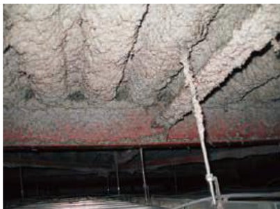
天井裏の吹付け材
