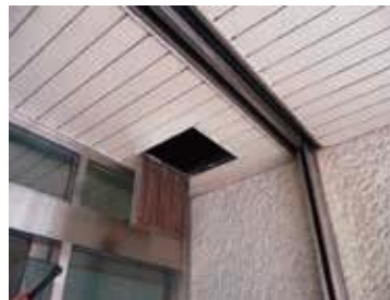
玄関横シャッター周り
