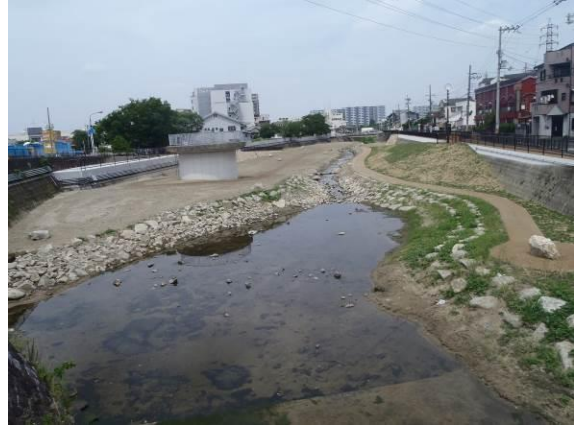
寝屋川「川勝水辺ひろば」(平成 25 年 6 月完成)
