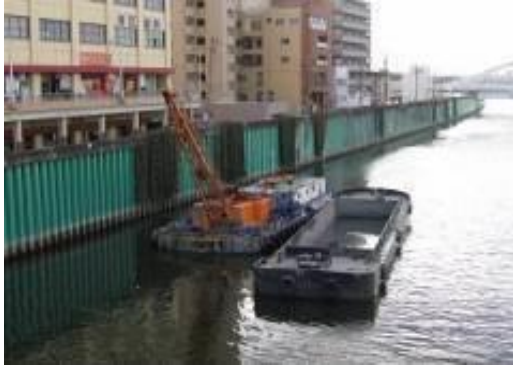
図 3-3-22 浄化浚渫(寝屋川)
