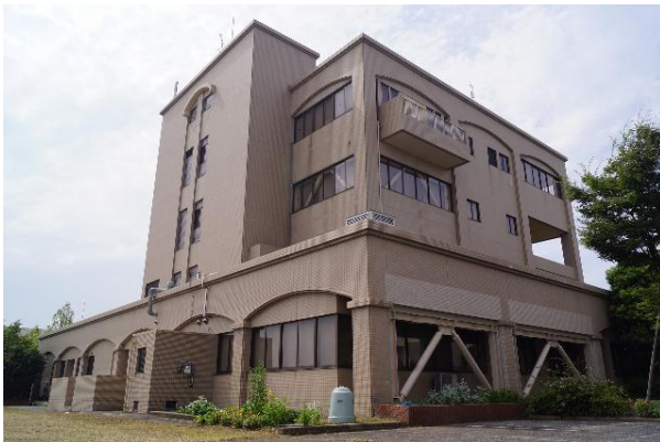
図 3-2-12 処理場・ポンプ場施設の耐震化
