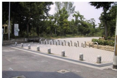
出入口の改修
