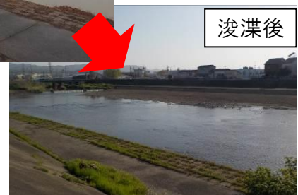
堆積土砂除去
