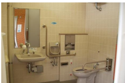
多目的トイレ
