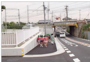
歩道の整備 河内長野美原線 (大阪狭山市)
