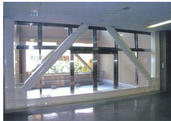
図 3-2-12 処理場・ポンプ場施設の耐震化
