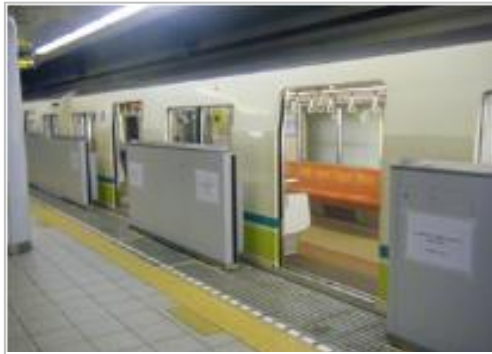
可動式ホーム柵の設置状況(扉式) (提供:大阪市交通局)
