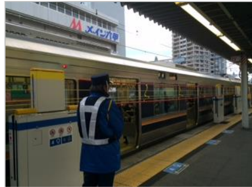
昇降式ホーム柵の設置状況(ロープ式) (提供:JR西日本)
