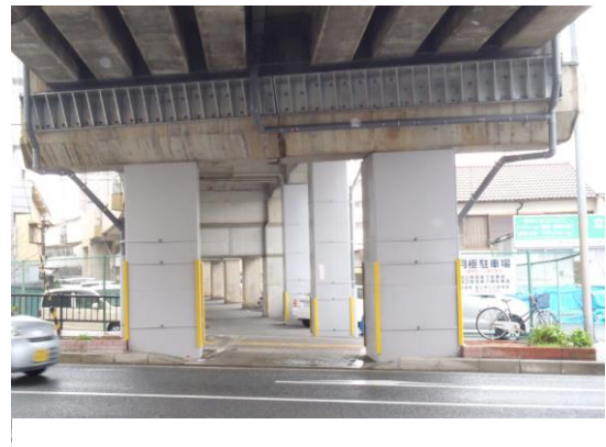
図 3-2-11 鉄道施設の耐震性強化の例
