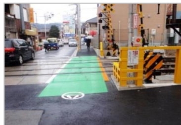
踏切内歩道設置 桜井停車場線 (箕面市)
