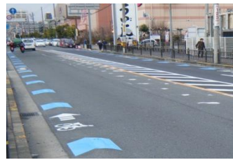
自転車レーンの設置 大阪高槻京都線（茨木市）
