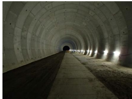
大和川線 (大都市圏環状道路の強化)
