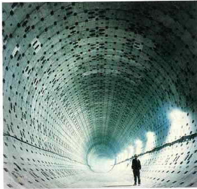
寝屋川南部地下河川
