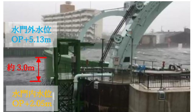
高潮対応の状況（木津川水門）
